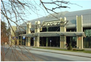
Budynek terminala Lotniska w Bydgoszczy.
